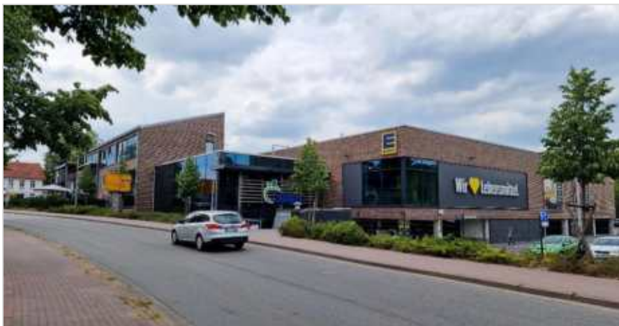
Abbildung 22: Großflächiges Nahversorgungsangebot in Trittau (CIMA 2023)
